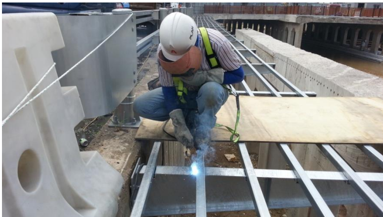
브라켓 홈에 각관을 끼운 후 일괄용접
