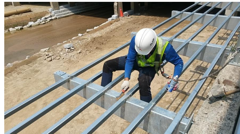
용접 잔해물 제거
